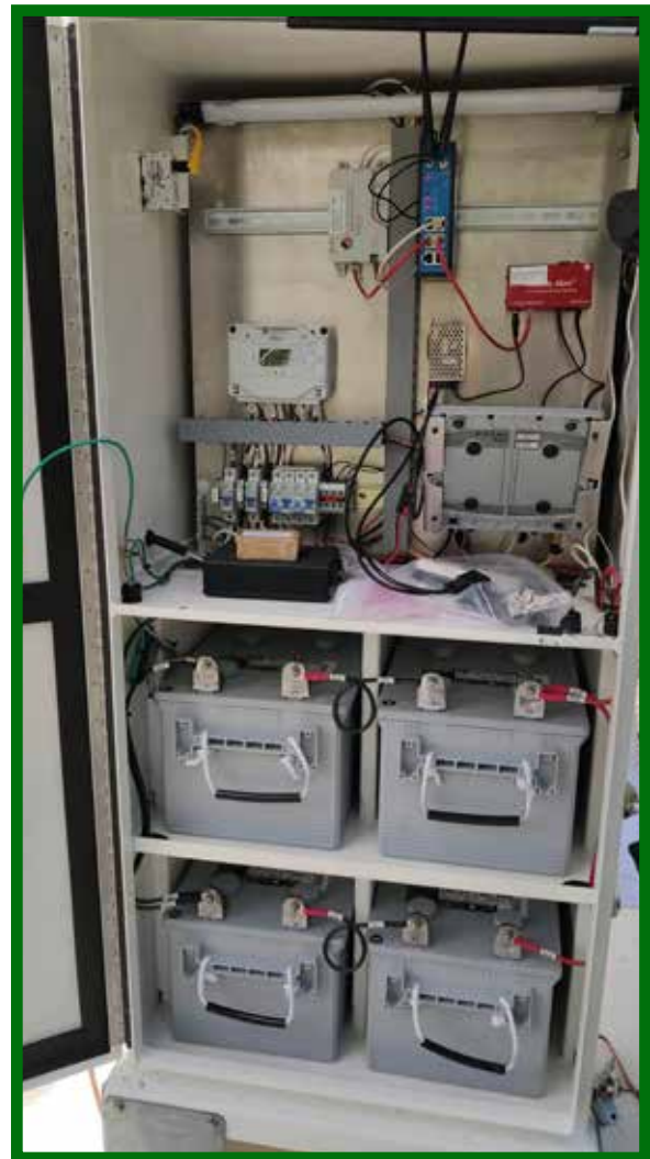
Figura 4. A la izquierda configuración interna del gabinete y Estación GNSS autónoma instalada
