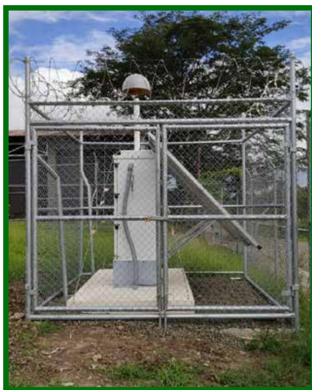
Figura 7. Estaciones GNSS Autónomas integradas a la Red de Estaciones GNSS RN-IGN 2021 Fuente: Carlos Eduardo Gómez Salazar, IGN sitios GNSS: LCRZ.
